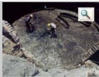
* Limpieza de cisternas y manejo de los residuos generados
